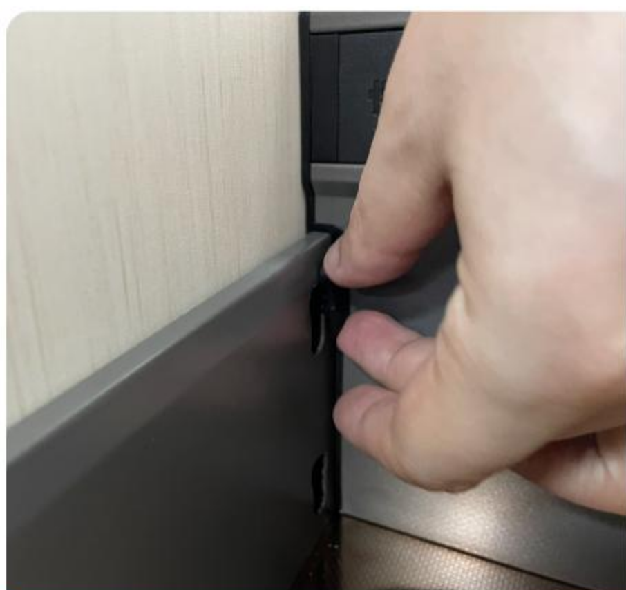
安装门板螺钉孔装饰盖
